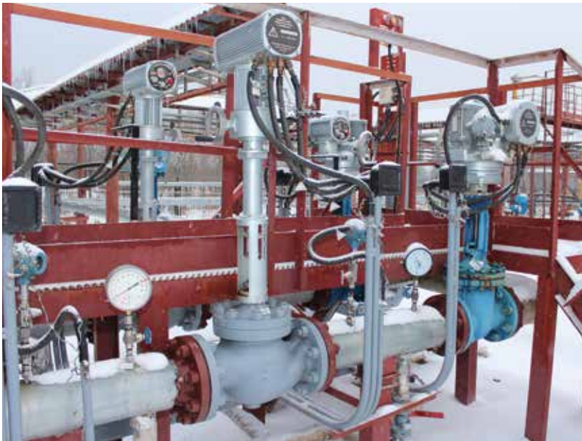
Электродвигатели РэмТЭК на узле подключения к магистральному нефтепроводу (ООО «Томскнефтепереработка»)
