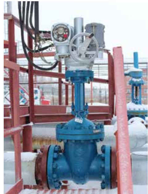
Электродвигатели РэмТЭК на узле подключения к магистральному нефтепроводу (ООО «Томскнефтепереработка»)
