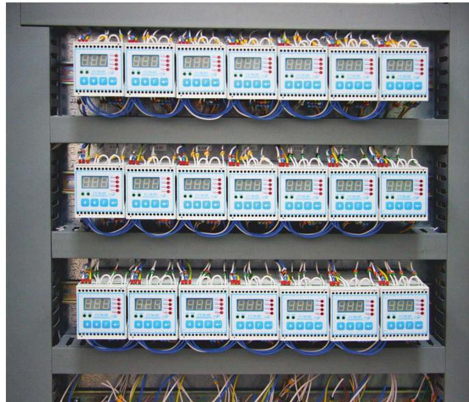
Система контроля загазованности на базе газосигнализаторов GSM-05
