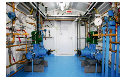
**Насосные станции** предназначены для перекачки нефти, нефтепродуктов, природного, попутного нефтяного газа, сжиженного газа, газового конденсата, воды, химических реагентов и автоматизированного поддержания заданного давления на выходе.
