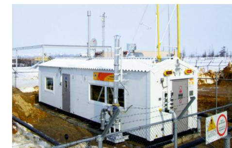
**Блоки подготовки, редуцирования и распределения газа** предназначены для подготовки топливного газа для газопоршневых и газотурбинных приводов компрессорных станций, электростанций и прочих потребителей.
