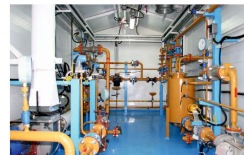
**Блоки измерения параметров качества нефти** предназначены для автоматического определения физико-химических показателей качества нефти согласно ГОСТ Р 51858-2002, автоматического и ручного отбора проб нефти для последующего проведения анализа качества нефти.
