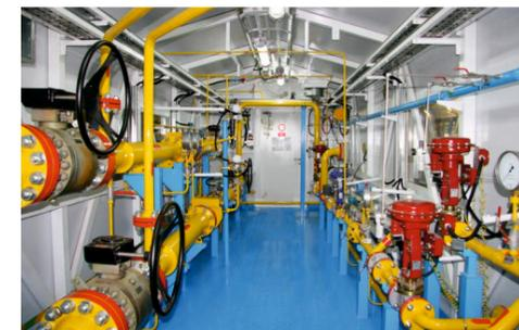
**Узлы учета газа** предназначены для определения количества, параметров качества, автоматизированного учета природного и попутного нефтяного газа.
