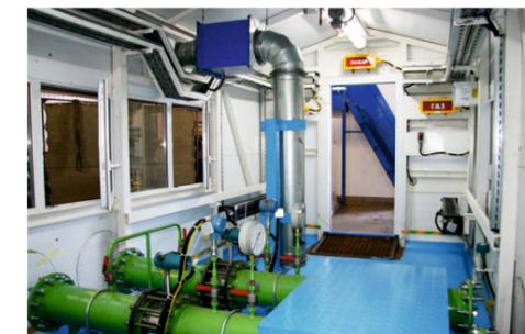
**Узлы учета воды** предназначены для автоматизированного учета подтоварной (пластовой) воды.
